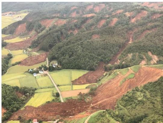
厚真町 土砂災害の被害状況① (川崎市消防局提供)
